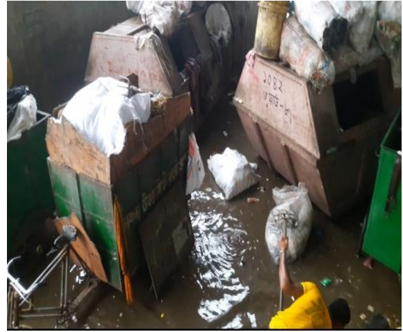
চিত্র : এসটিএস রাইখোলা, মিরপুর (রাস্তার থেকে এর গ্রাউন্ড ফ্লোর অনেক নিচু হওয়ায় পানি জমা হয়ে আছে) ।
